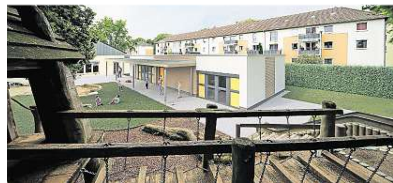
Die Gebag errichtet auf einem Eckgrundstück in Wanheimerort ein Familienzentrum. Der Rohbau wurde in dieser Woche fertiggestellt. VISUALISIERUNG: GEBAG
